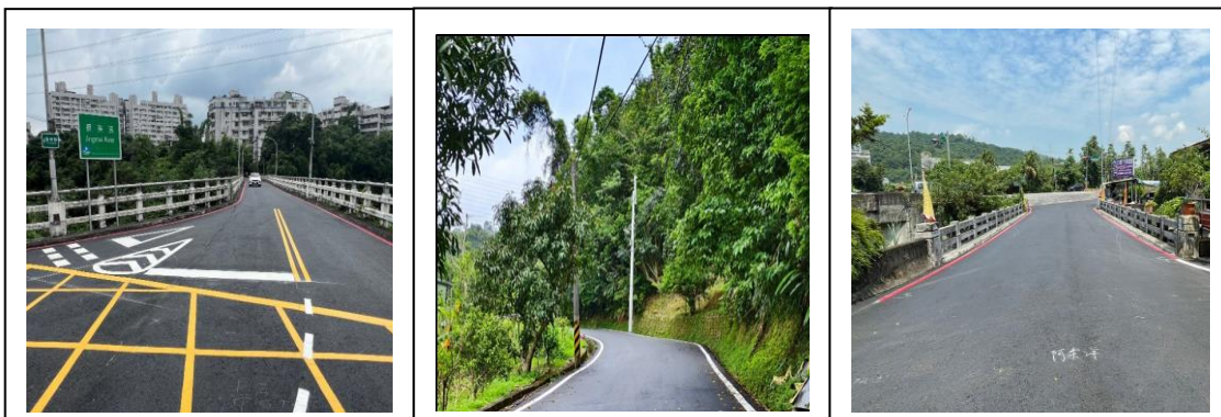
圖十一 道路路面養護及改善工程
